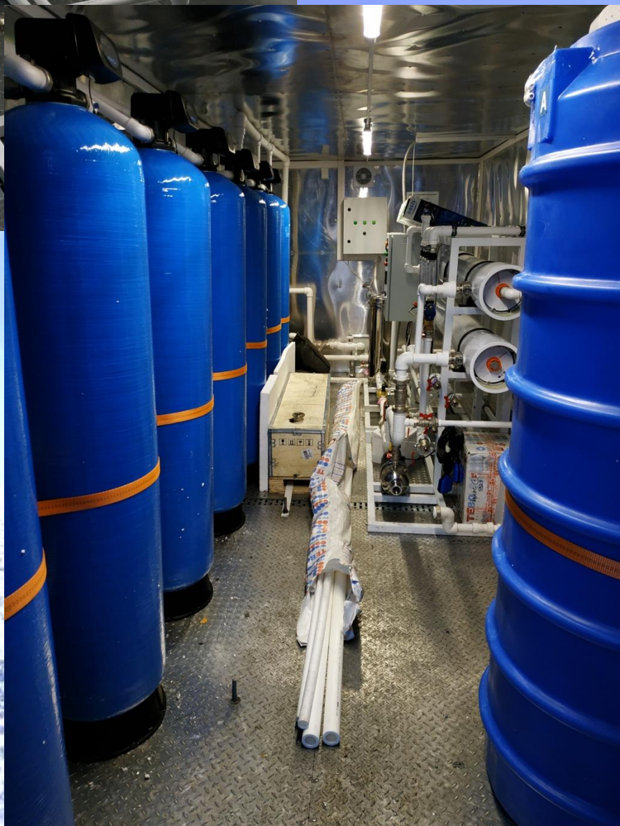
Установка АФС- М Контейнерного типа производительностью 3-6 куб.м\час
