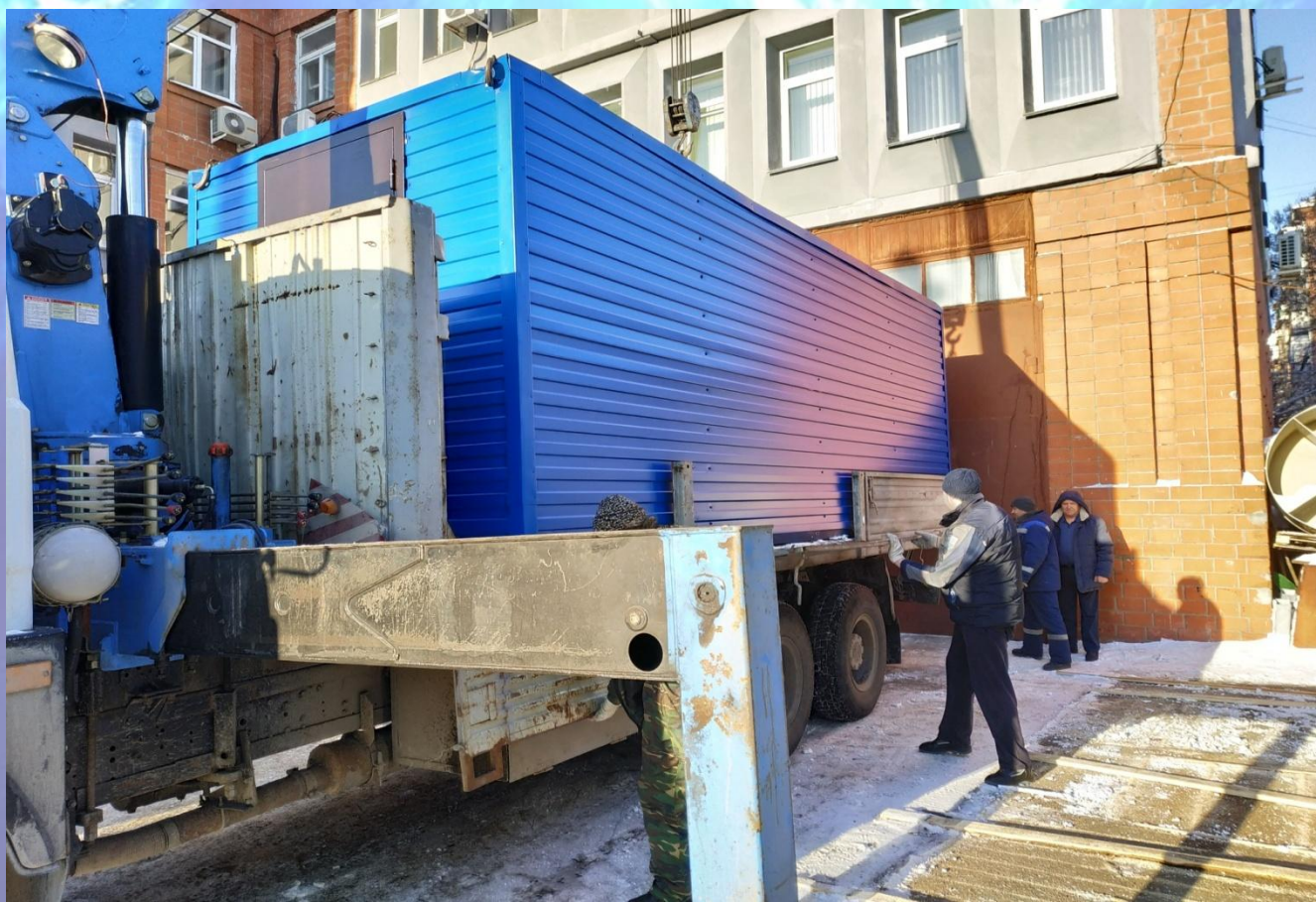
Установка АФС- М контейнерного типа производительностью 3-6 куб.м\час
