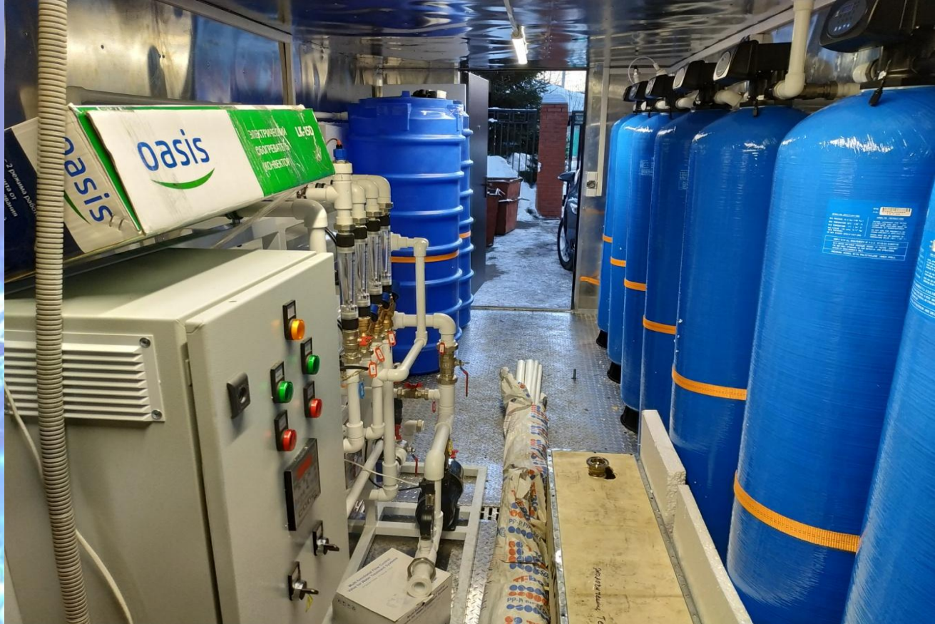
Установка АФС- М контейнерного типа производительностью 3-6 куб.м\час
